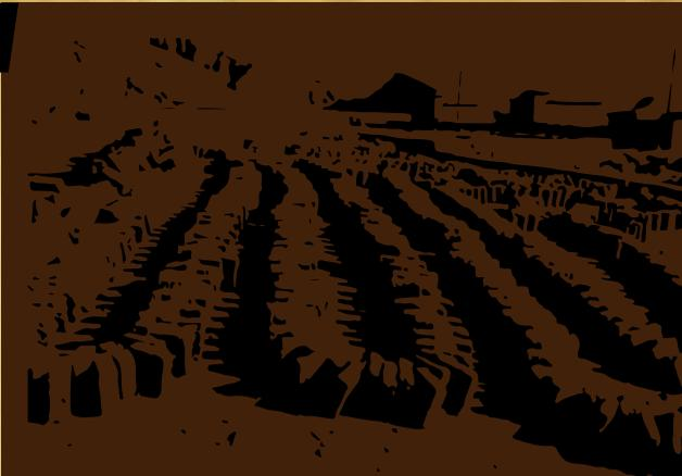
A fabricação dos tijolos de argila, amassados com palha e cozidos ao sol, que se usa no Oriente desde os tempos mais antigos até hoje. Os tijolos são depois levados à parede recobertos com nova argila, e formam um produto que se adapta a todas as formas, mas que é degradável pelas intempéries; portanto dura somente se for submetido a uma manutenção contínua.
