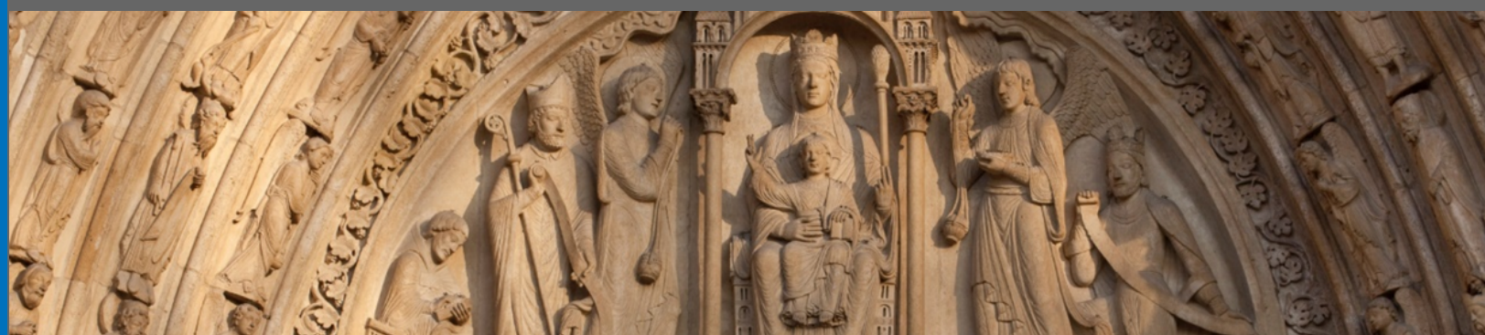
Portão Sainte-Anne Catedral Notre-Dame de Paris Construção: 1200
